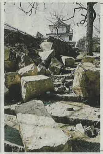
阪神・淡路大震災で石垣が崩れた明石城
